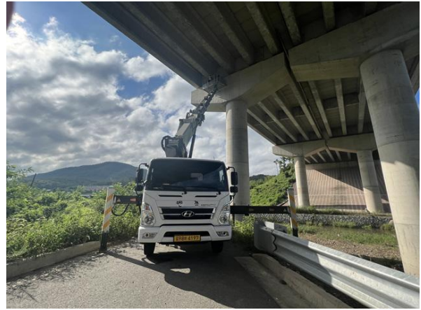
고소점검차를 이용한 근접조사
