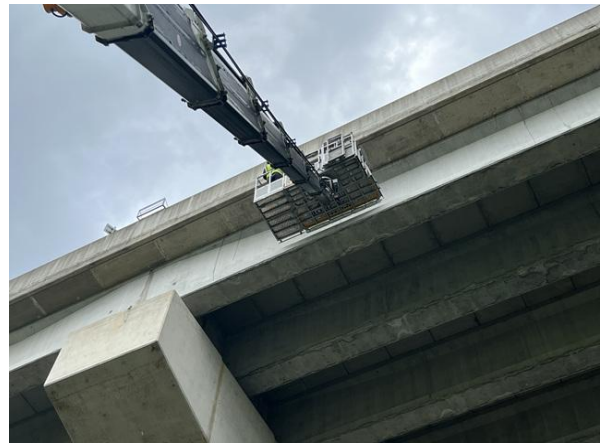
고소점검차를 이용한 근접조사
