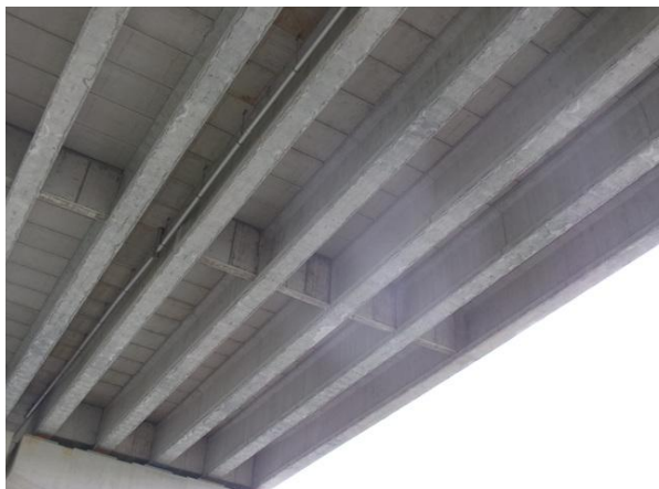
거더 및 바닥판하면 전경
